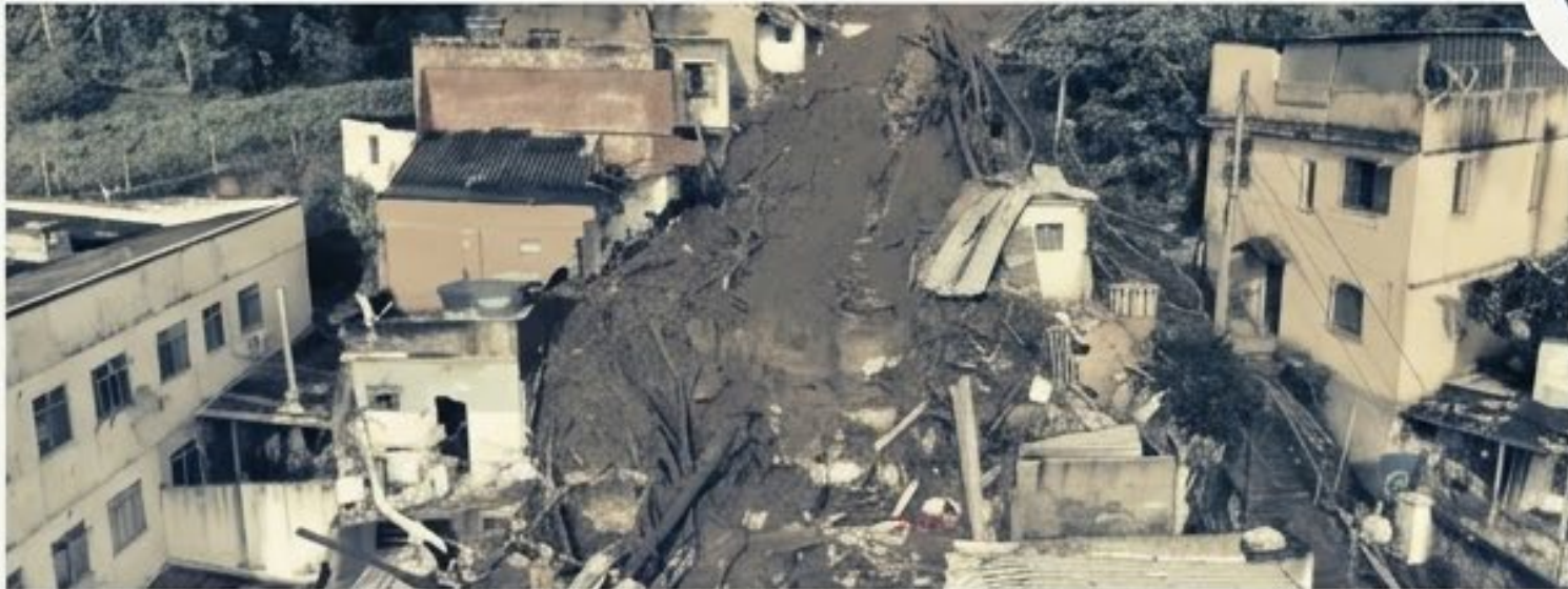
Deslizamentos: Colapso estrutural local.
